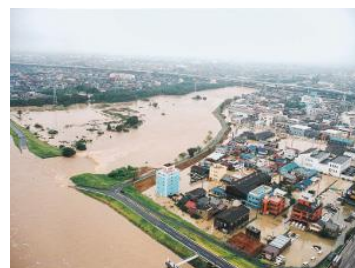
新川洗堰の出水
